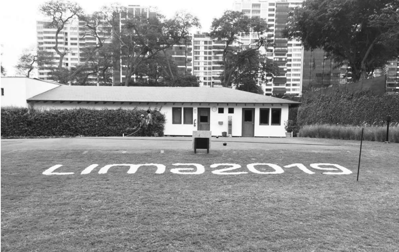
Lima Golf Club. Fachada posterior zona personal de operaciones, área de caddy house. Foto L. Meléndez, 2019
