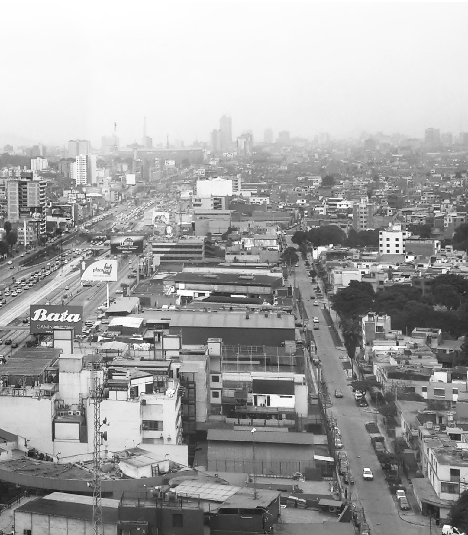
Vía Expresa, Paseo de la República. El Metropolitano de Lima no aprovecha sus estaciones como espacios de encuentro, servicios y alta densidad, tal como se muestra en esta imagen del distrito de La Victoria, ni en el resto de su recorrido. Foto: Sharif Kahatt, 2018.
