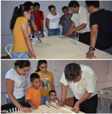
Figura 10 y 11. En la mesa de trabajo se colocaron marca para medir los tubos a cortar de tres medidas diferentes, utilizando los tres colores indicados.
