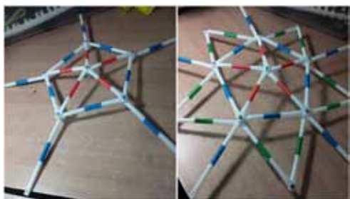
Figura 3. Construcción del nivel 3 del domo, empezando a formar los bordes y el interior de los hexágonos.
