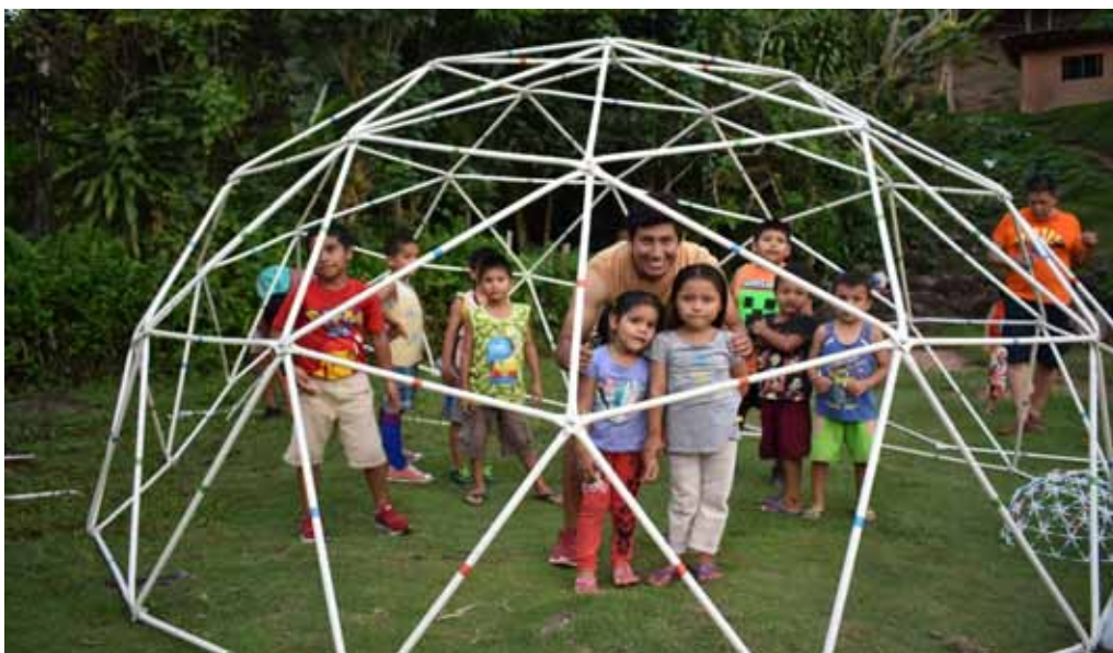
Figura 1. Domo Geodésico de Frecuencia 3 en plena construcción en la Institución Educativa Inicial 105 en el Centro Poblado de San Antonio del Rio Mayo en la Provincia de Lamas, Departamento de San Martín
