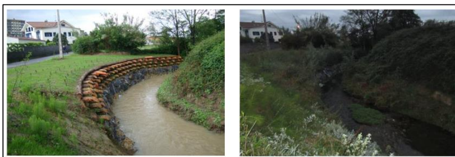
Figura N° 8. Entramados de madera o muros Krainer a los 3 y 5 meses después de su construcción
