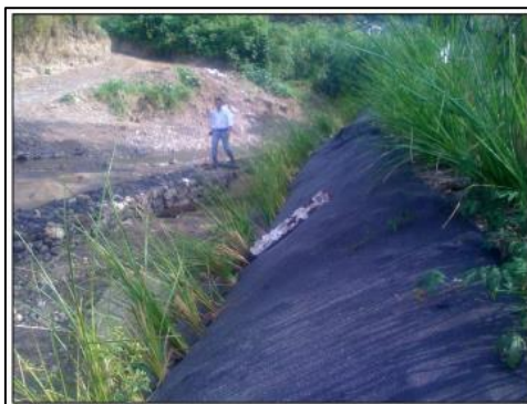
Figura N° 7. Protección de ribera. Boca del monte, agosto 2011
