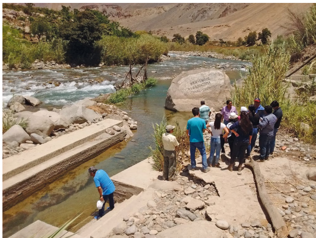
Vista, Bocatoma del Canal de San Marcos, captación de agua para consumo humano, derivación del río Cañete.
