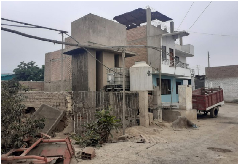
Figura 14. Viviendas que ocupan la parte posterior de la casa hacienda Retes, dejando un pequeño espacio (“calle”) de separación. Fuente: archivo personal (16.12.2019).
