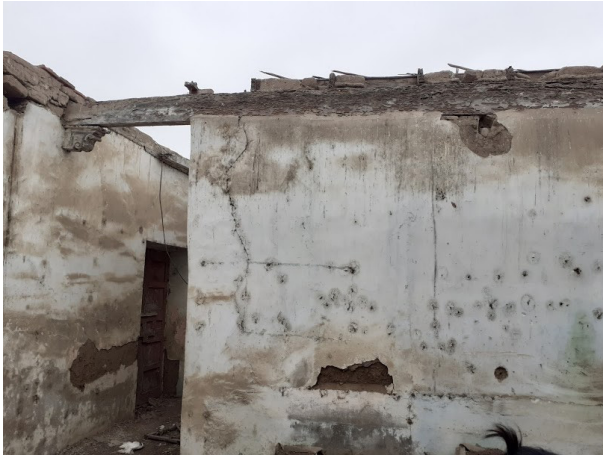
Figura 8. Estado actual de los muros del recinto 7 (patio interior) al que se accede por un angosto pasaje desde el portal de ingreso. Fuente: archivo personal (16.12.2019).
