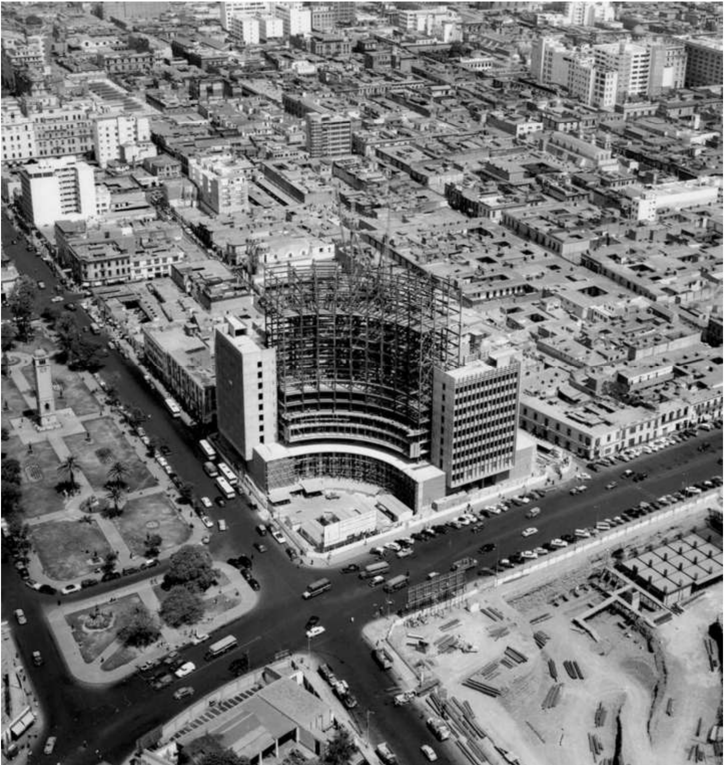
Ministerio de Educación, Lima. 1951-1956. Enrique Seoane. Obra en construcción. Fuente: Gunther, Mitrani, 2013, p. 13.
