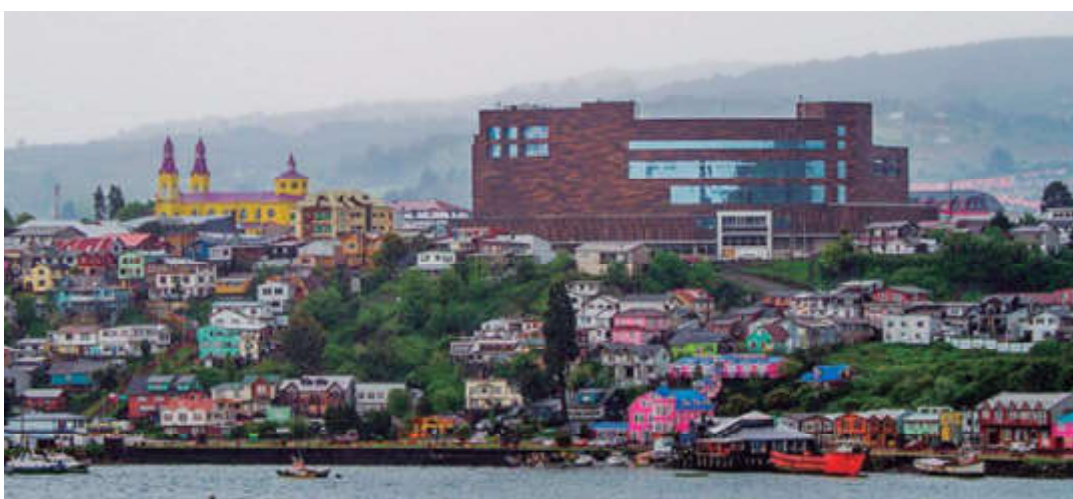
Figura 6. Mall Paseo Chiloé e Iglesia San Francisco. Castro. Provincia de Chiloé. Foto: M. Bello, 2017.
