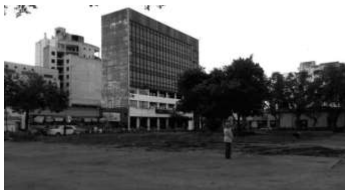
Figura 19. Fotografía de la demolición de plaza Olmos. Foto: Mabel Carbonari. 2016.
