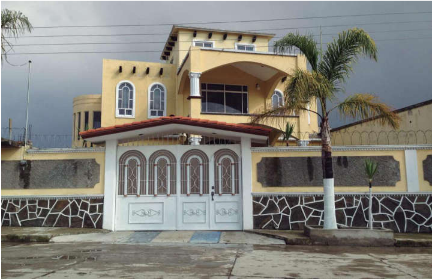
Figura 1. Vivienda construida con planos enviados de EUA. Fuente propia, visita a la localidad, abril 2017.
