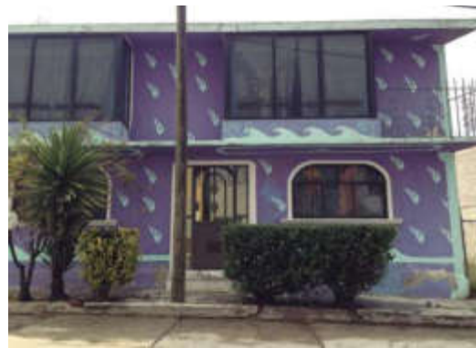
Figura 7. Vivienda mejorada de la familia que se fue, San Simeón. Fuente propia, visita a la localidad, abril 2017
