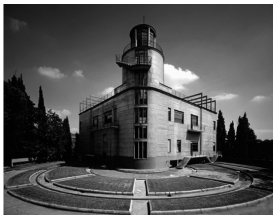
Figura 1. Vista principal de la Villa Girasol, en donde se observa la base circular y los rieles para que pueda girar por medio de ruedas impulsadas por motor. Fuente: http://www.italianways.com/wp-content/uploads/2015/03/villa-girasole-01.jpg
