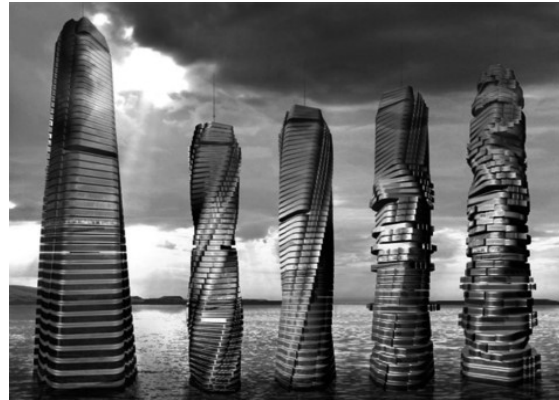
Figura 3. Perspectivas de la Dynamic Tower y sus diferentes formas que puede tomar consecuencia de los giros independientes de cada uno de sus pisos. Fuente: http://www.arabia-nindustry.com/static/content/images/larger/32418-337886.jpg
