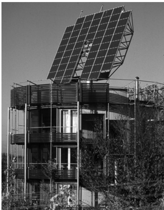
Figura 4. Vista general de Heliotropo y la estructura ubicada en el techo que sirve de soporte a los paneles fotovoltaicos, que captan la energía que alimenta al motor que permite el movimiento giratorio de la casa. Fuente: http://www.rolfdisch.de/files/pics/5136heli_weinberg_kopie.jpg
