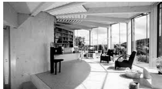
Figura 8. Vista interior de la sala de Heliotropo, donde se observan las secciones estructurales ensambladas a la columna central estructural. Fuente: https://www.schwaebisch-hall.de/content/dam/dambsh/wohnen-und-leben/energie-sparen/sonnenenergie/so-funtionieren-sonnenhaeuser/02-Sonnenhaus-Solararchitektur.jpg
