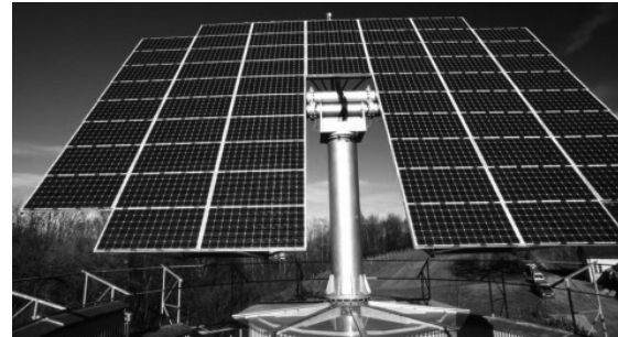
Figura 7. Vista cercana de la estructura pivotante de vela que soporta los paneles fotovoltaicos en el techo de la casa. Fuente: http://images.gizmag.com/inline/heliotrope-6.jpg
