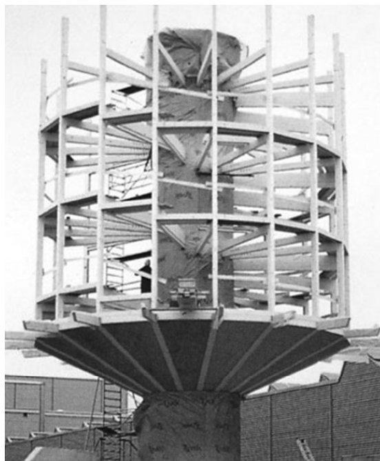
Figura 6. Vista durante el proceso constructivo, en donde se observa la estructura de soporte de la columna central y los pisos circundantes fijados alrededor de la misma. Fuente: http://www.auro.de/bilder/referenzen/bilder_referenzen_dt/heliotrop/heliotrop_4.jpg
