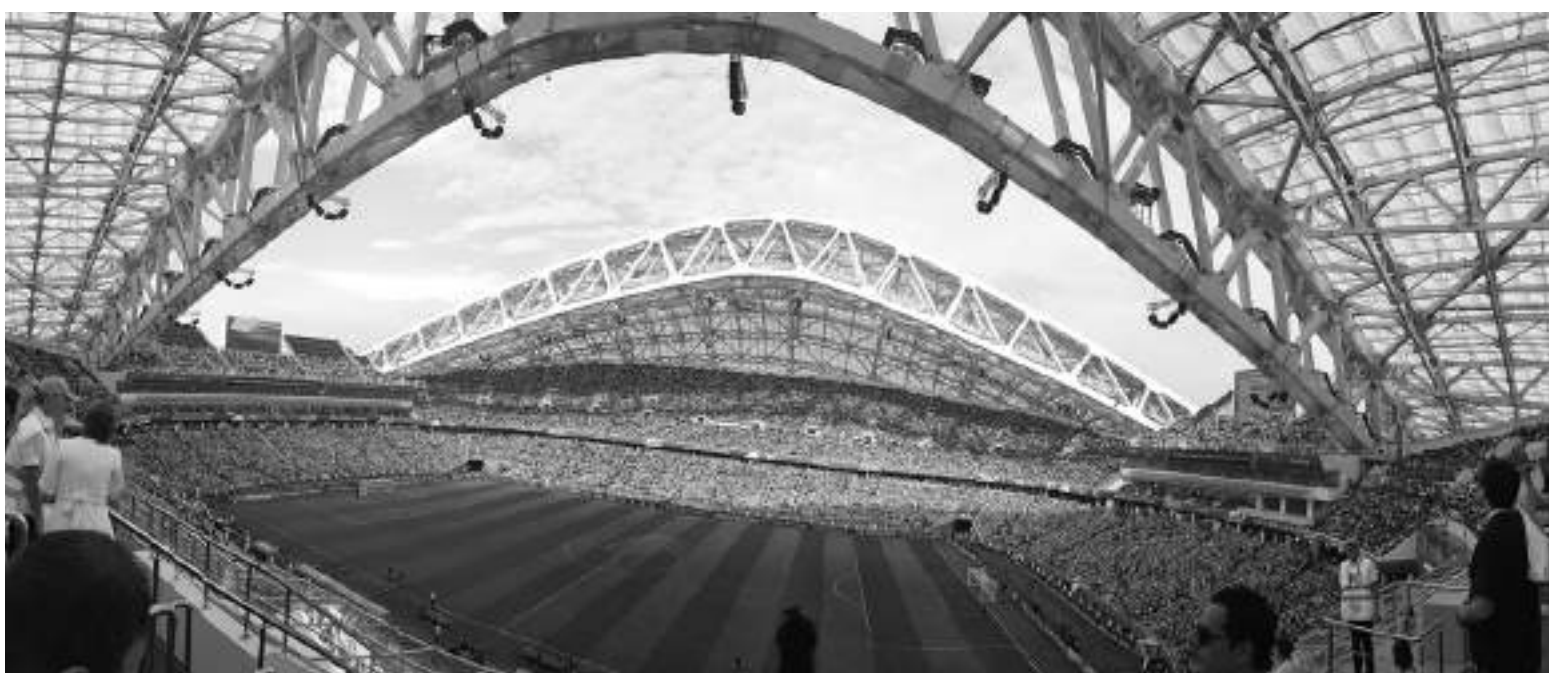
Figuras 33 y 34. Estadio de Sochi. La monumentalidad expresada en las dos vigas que recorren longitudinalmente el estadio, dando forma a las envolventes. Figura 33, foto: C. Castañeda, 2018. Figura 34, foto: Adolfo Morey, 2018.
