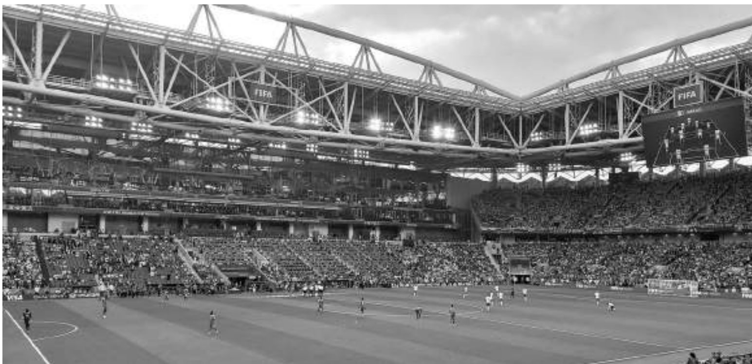
Figura 37. Spartak Stadium de Moscú. Instalaciones, sistema de comunicación y estructura metálica que confieren funcionamiento al estadio. Foto: C. Castañeda, Mundial Rusia 2018.
