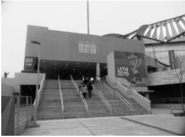
Villa Deportiva Nacional. San Luis. Lima. Vista de ingreso Av. Canadá
