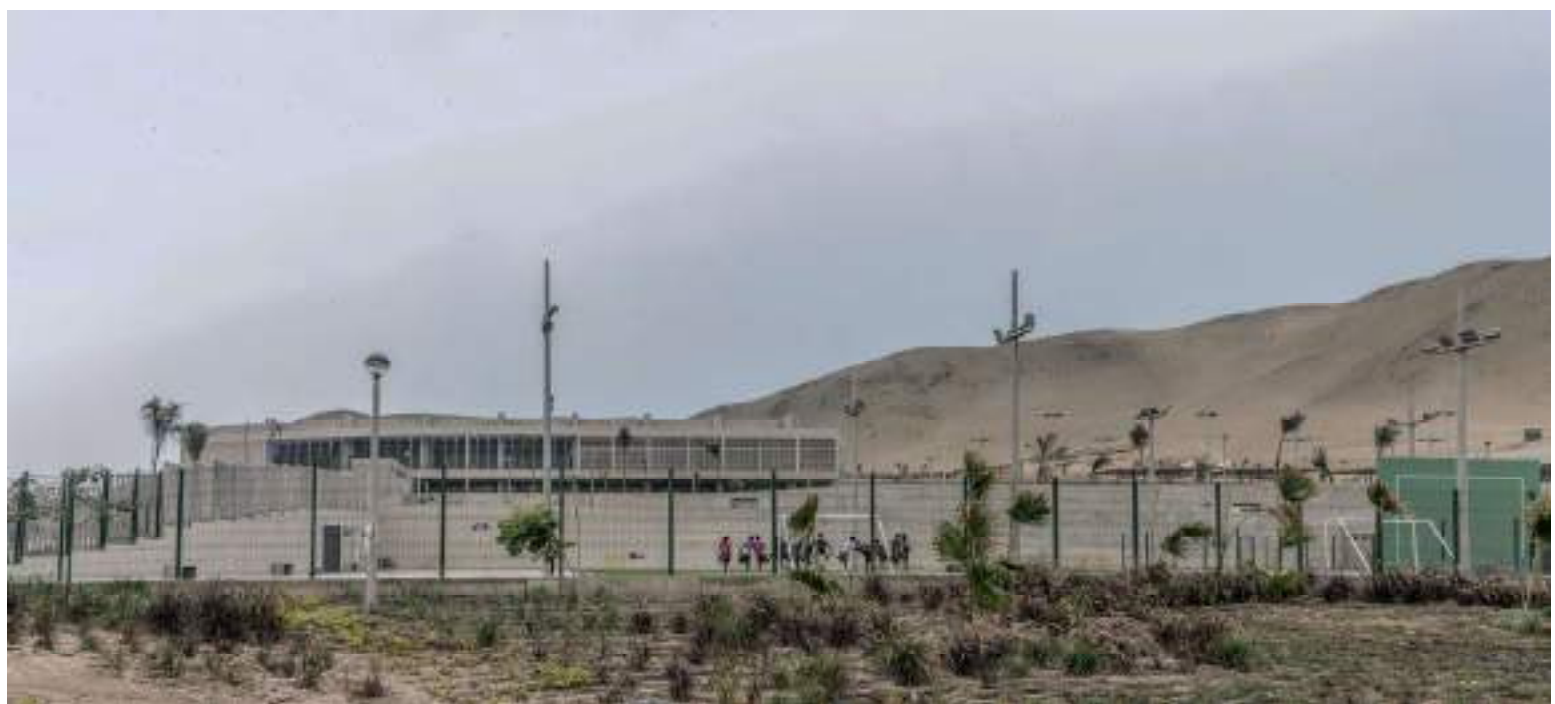
Parque zonal Santa Rosa. FD ARQUITECTOS S.A.C. Foto Eleazar Cuadros
