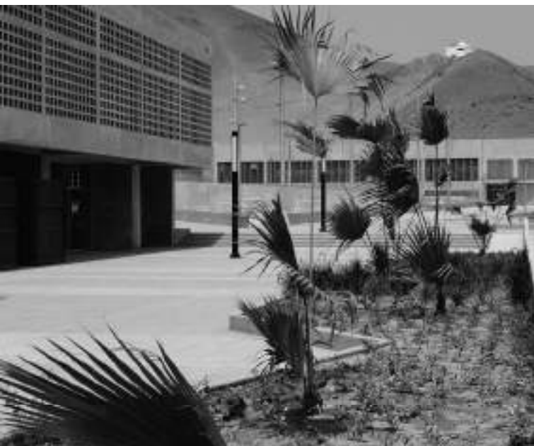
Parque zonal Santa Rosa. FD ARQUITECTOS S.A.C. Foto Eleazar Cuadros
