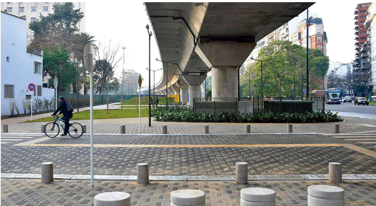
Figura 2. Nuevo espacio público en el bajo viaducto de la línea Mitre del ferrocarril, por donde corrían las vías. Ciudad Autónoma de Buenos Aires, 2019.
