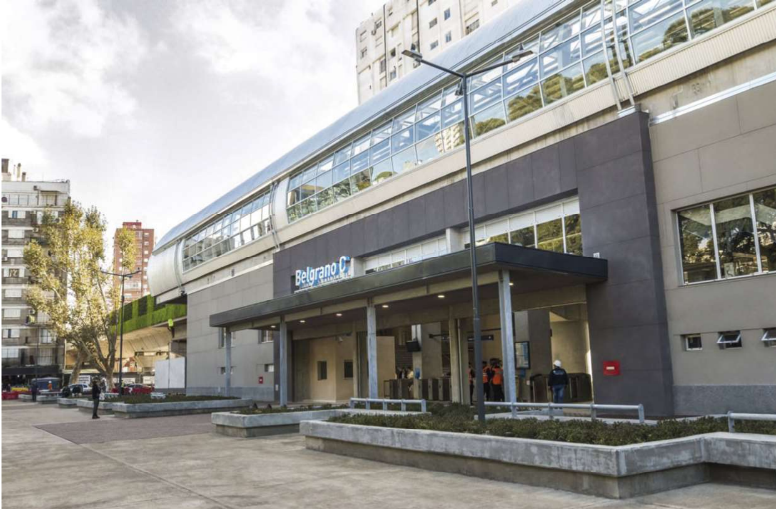
Figura 1. Estación Belgrano “C” de la línea Mitre del ferrocarril, nuevo viaducto. Ciudad Autónoma de Buenos Aires, 2019. Fuente: https://www.buenosaires.gob.ar/desarrollourbano/desarrollo/viaducto-mitre
