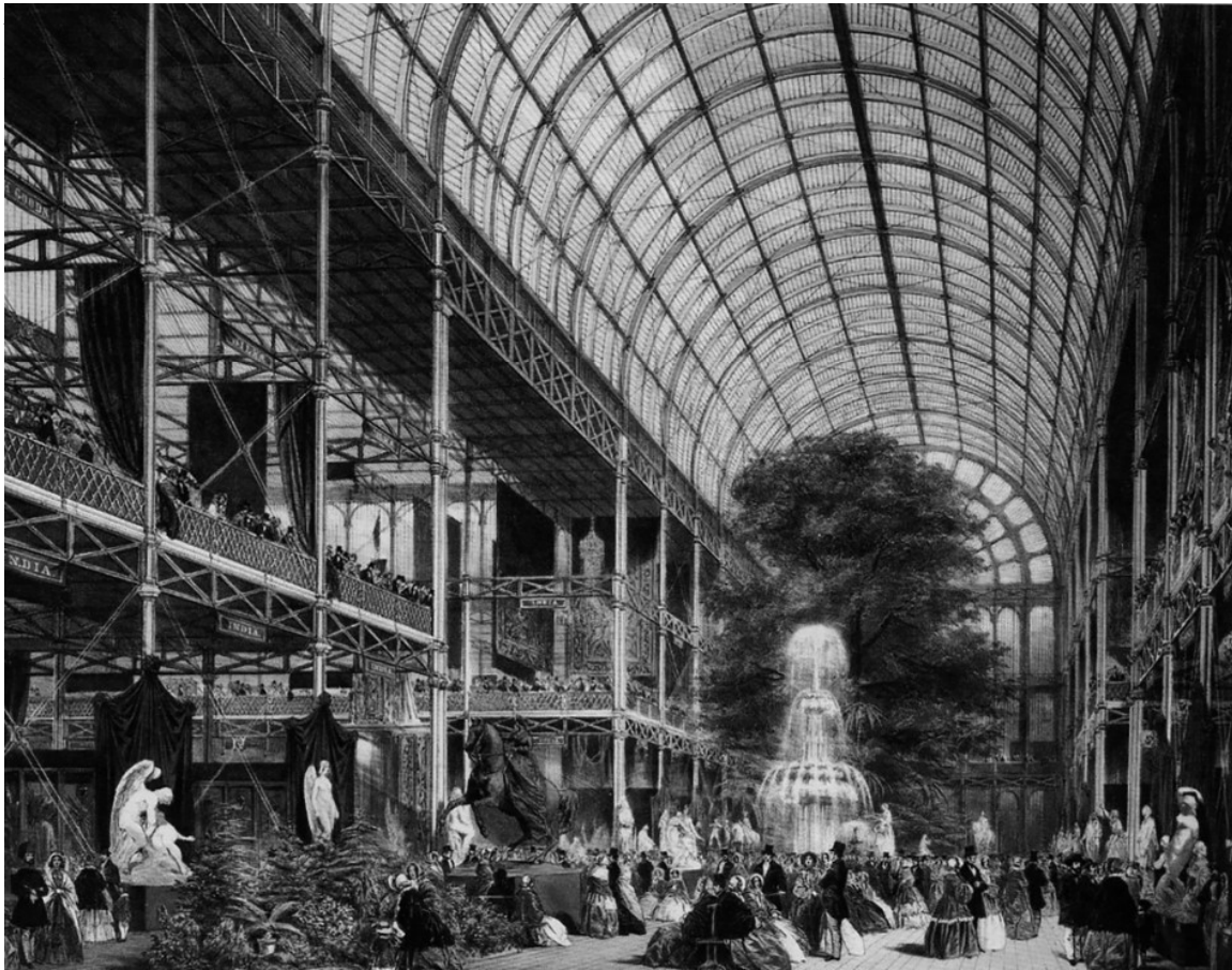
Figura 1. Palacio de Cristal, Londres, 1851, construido íntegramente en hierro y cristal.
