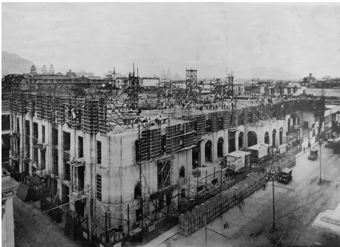
Figura 2. Avances en la construcción del Hotel Bolívar, 1924. Fuente: Ciudad y Campo y Caminos. N° 2, agosto-setiembre 1924
