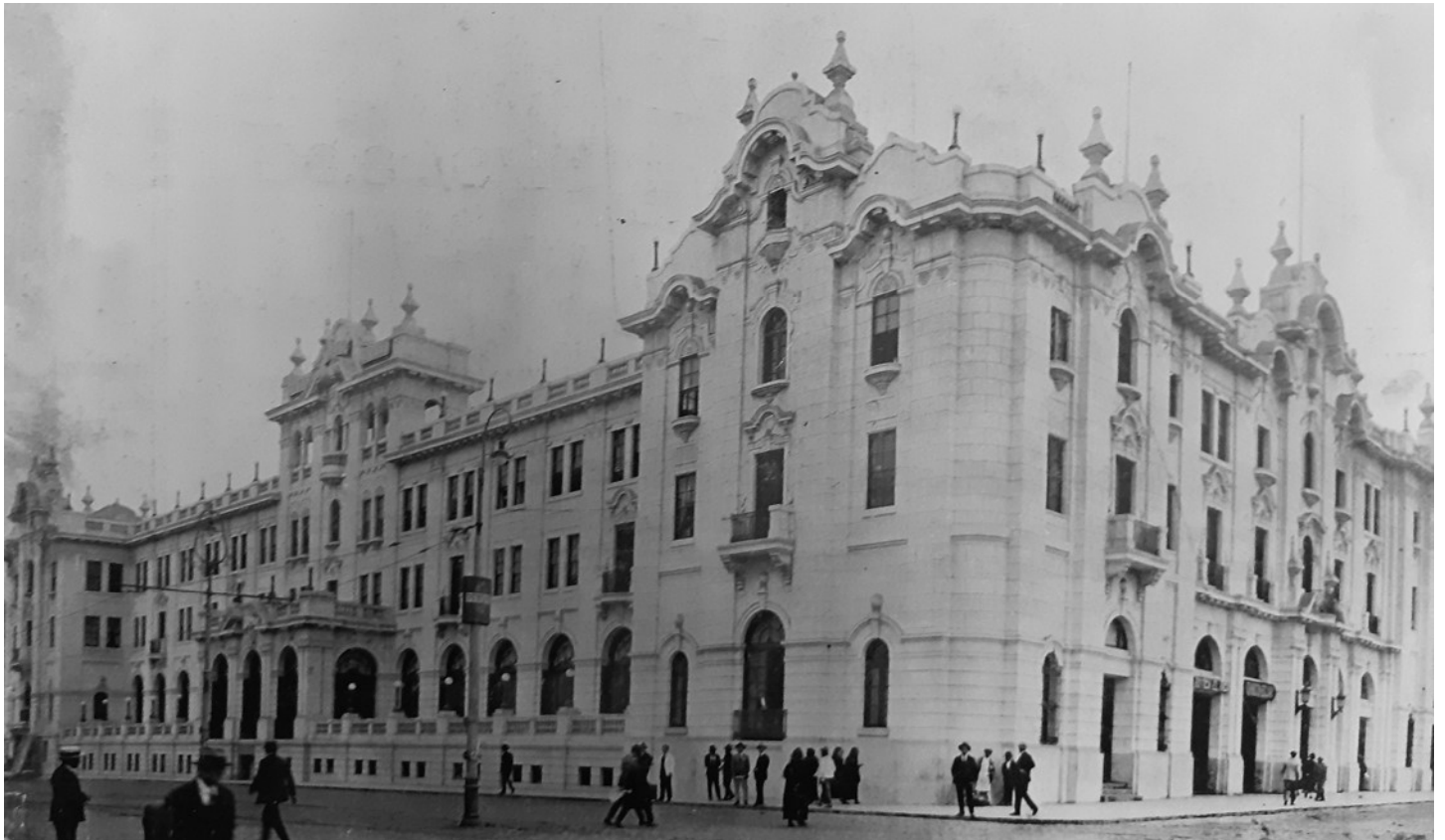
Figura 6. Culminación de los trabajos en el Hotel Bolívar, Lima, 1925. Vista en esquina de las fachadas hacia el Jirón de la Unión y avenida La Colmena. Fuente: Ciudad y Campo y Caminos. Nº 8, julio 1925.
