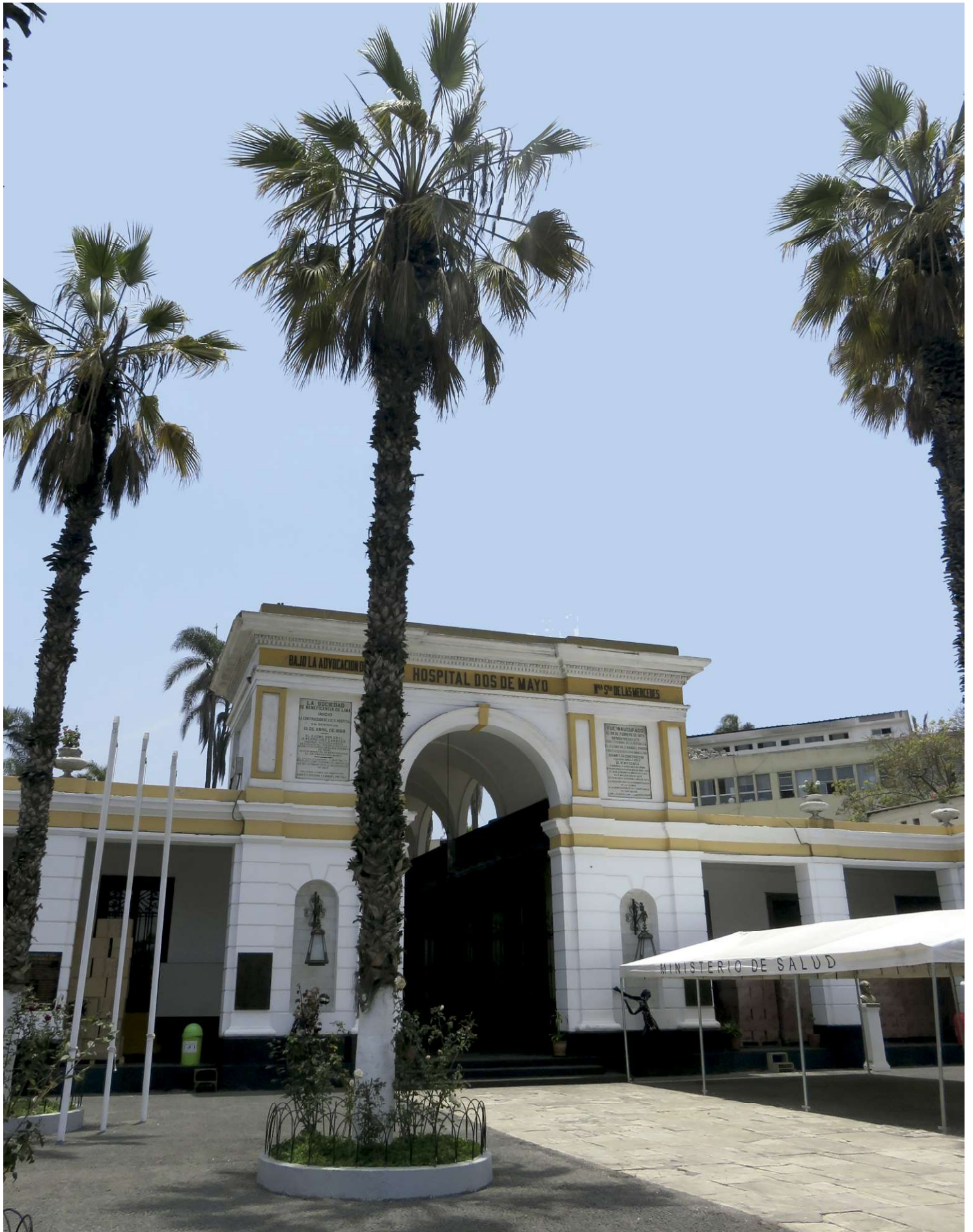
Hospital Dos de Mayo. Lima. Vista exterior del ingreso principal.
