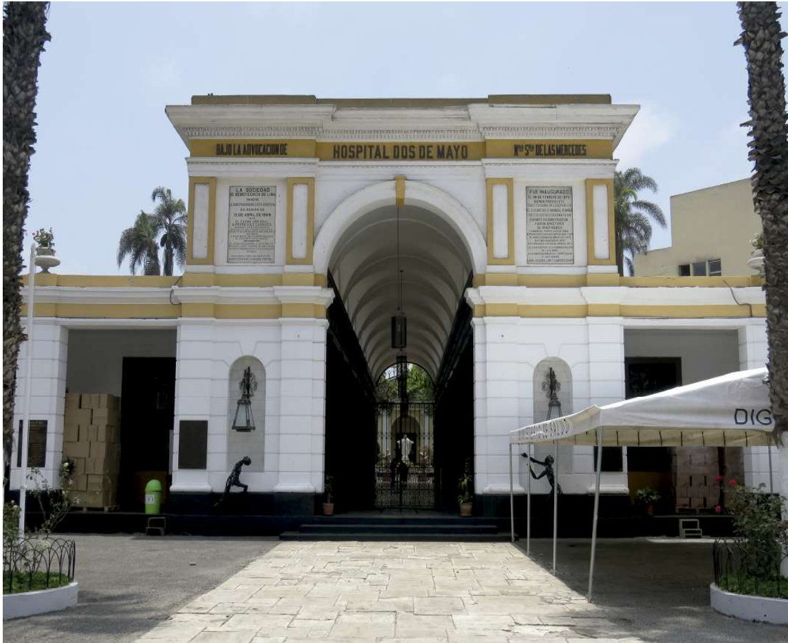
Figura 8. Hospital Dos de Mayo. Vista exterior del ingreso principal. Foto: Martuccelli, 2022.
