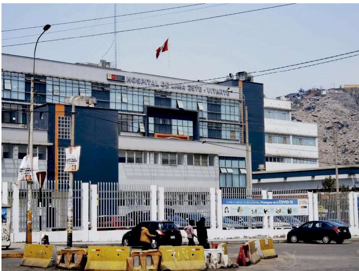
Figuras 12-15: Vistas exteriores del Hospital de Emergencias de Lima Este-Vitarte. Fotos de Leandro Vásquez, 2022.
