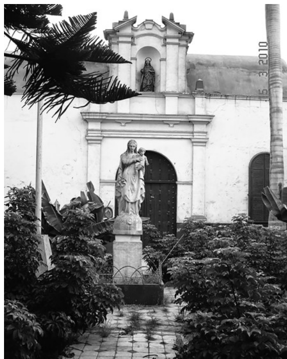
Figura 6: Vista de uno de los patios del claustro del Hospital Real de San Andrés, muestra de la influencia religiosa de su arquitectura. Foto: Stucchi, 2010. Recuperado de: http://psiquiatriahistorica.blogspot.com/2010/03/el-hospital-de-san-andres.html
