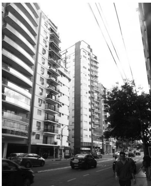
Figura 8. Edificios entre medianeras con losas en voladizo. Avenida Córdoba, Buenos Aires.
