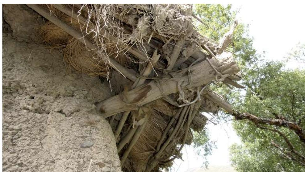
Figura 6. Detalle de nudo en la esquina de una casa. Se puede observar el encuentro de la llegada de las cañas a una estructura principal en la cual todas se encuentran amarradas.
