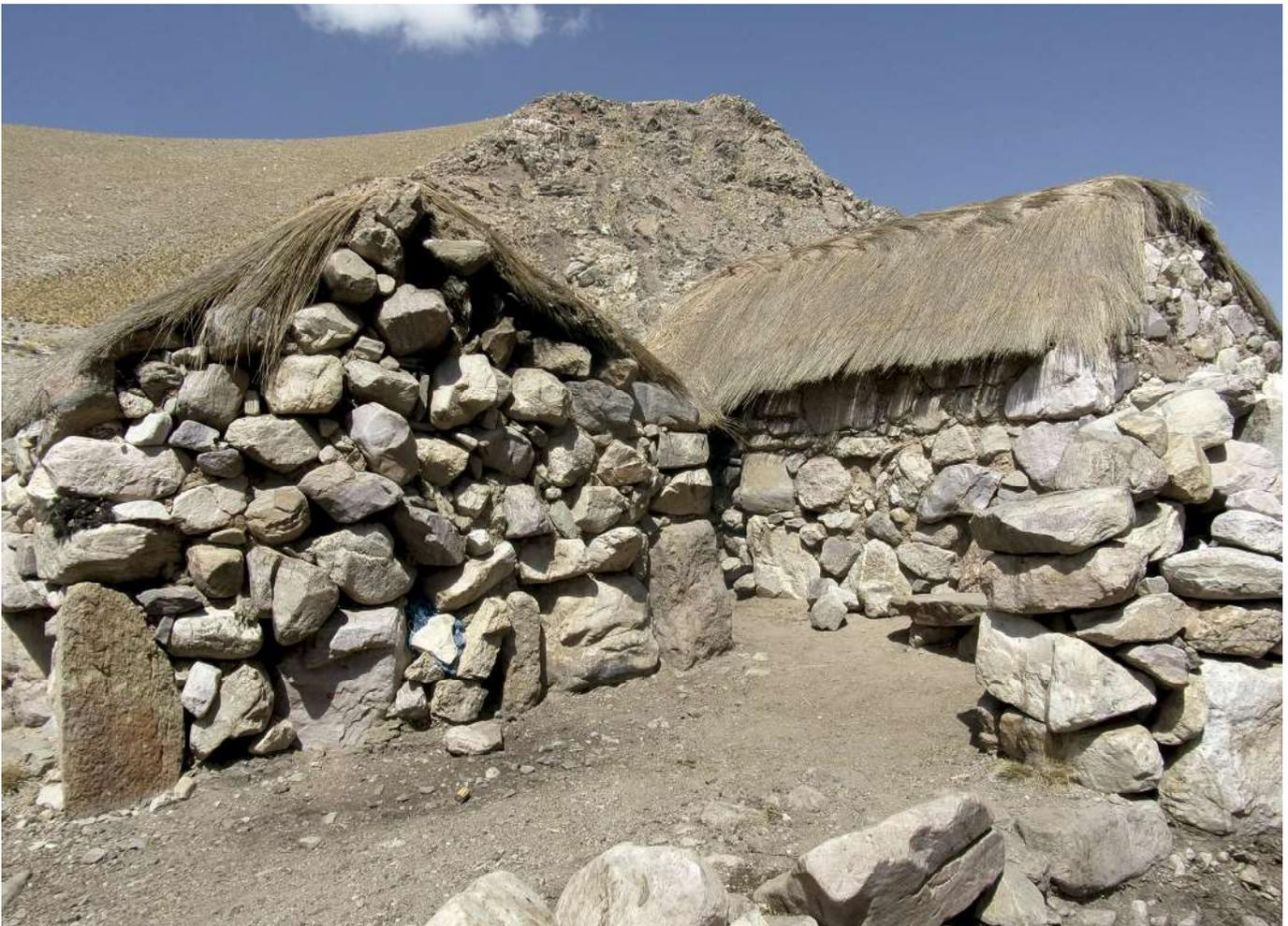
Figura 8. Puesto del Rincón en la Comunidad de San Francisco, realizada con muros de piedra y techo de paja walla.
