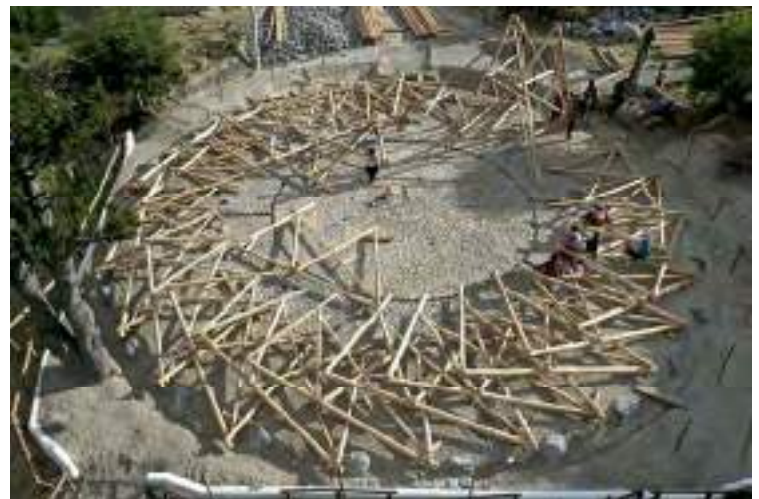
Veintiseis cerchas de madera local. Foto Marie Combette.
