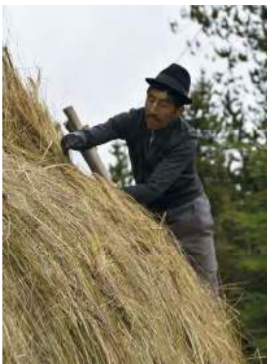
Colocación de cintas de cuerda de fibras. Foto Marie Combette.
