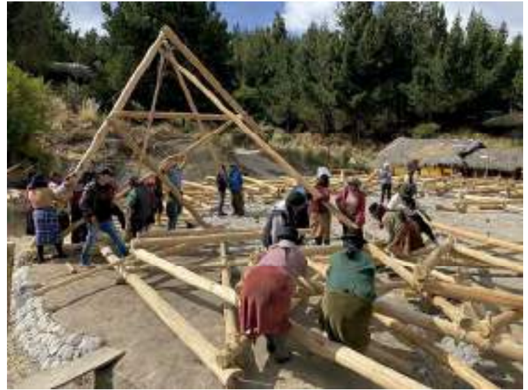
Montaje colectivo de la primera armadura. Foto Marie Combette.
