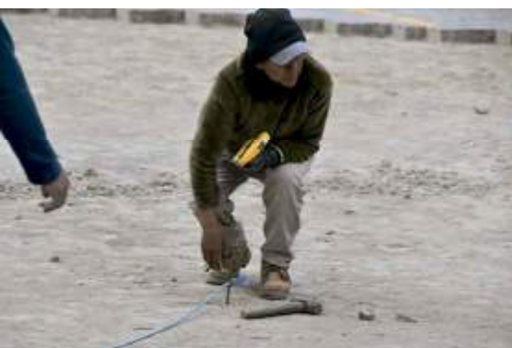
Comenzando el trabajo en el sitio.
