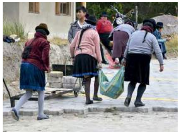
Preparando el terreno. Foto Marie Combette.
