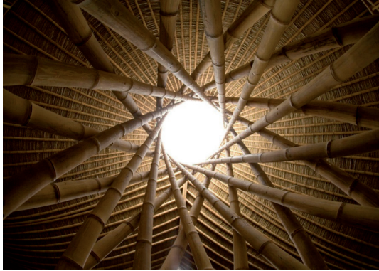
Figura N ° 2: Vista interior del techo.
