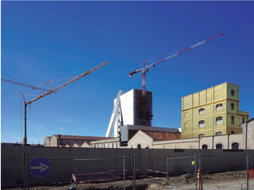
Fig. 9. Vista de la Nueva Torre en construcción desde la calle. Foto: OMA.
