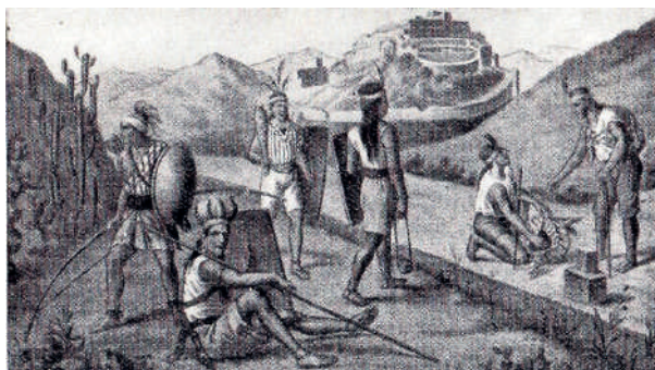
Fig. 17. Construcción de caminos incas.
