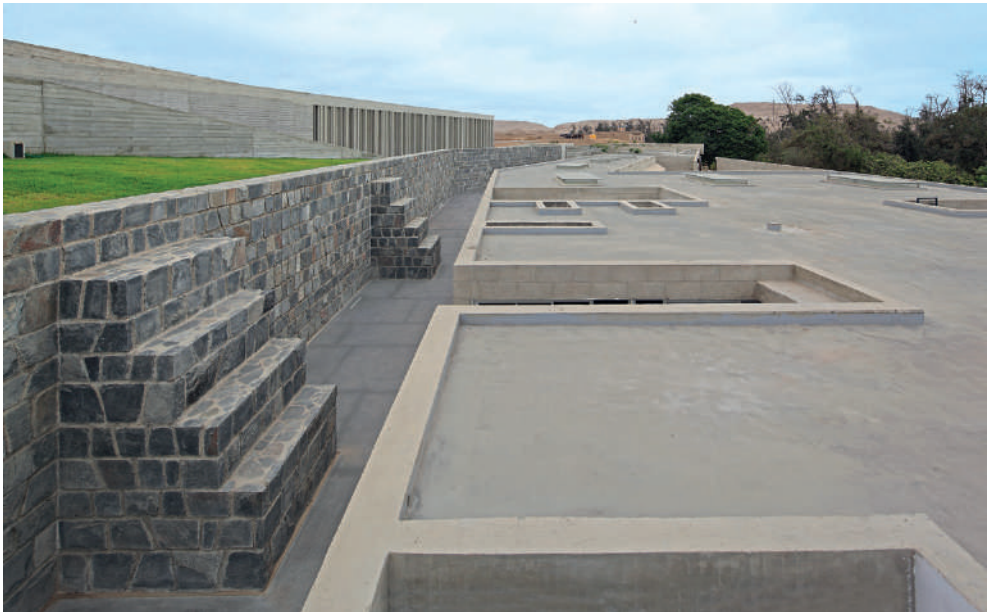
Fig.2. Vista superior del área administrativa. Fotografía: Juan Solano.
