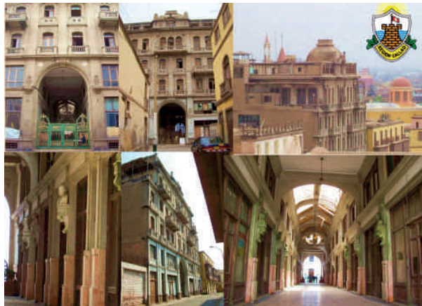
Figura 9. Collage que muestra el estado de Deterioro en el que se encontraba el Edificio y Pasaje Ronald años 1980 Aproximadamente. Fuente: Callao Monumental (2016).
