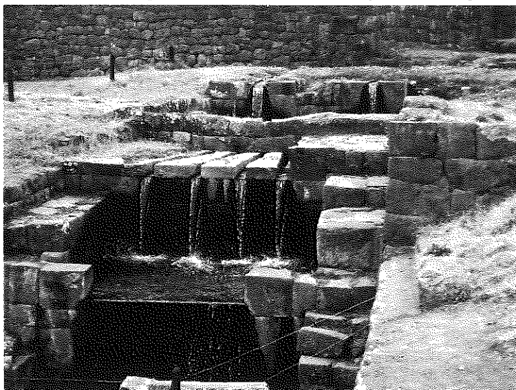
FOTO 10.- cabecera del sistema Tipón: Poza de reunión, Aireadores y Vertedero de pantalla rectangular
