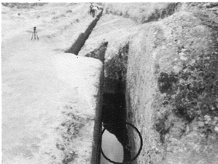
FOTO 12.- Canal tallado en roca viva con dos cambios de dirección en 90° para disipación de energía. Con salida mostrando rectificadores laterales de flujo
