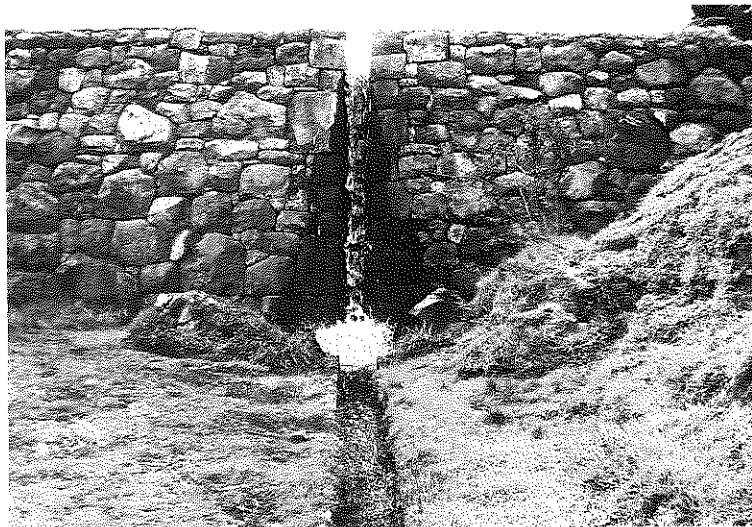
FOTO 9.- Saltos de una terraza a otra con desnivel medio de 7 metros
