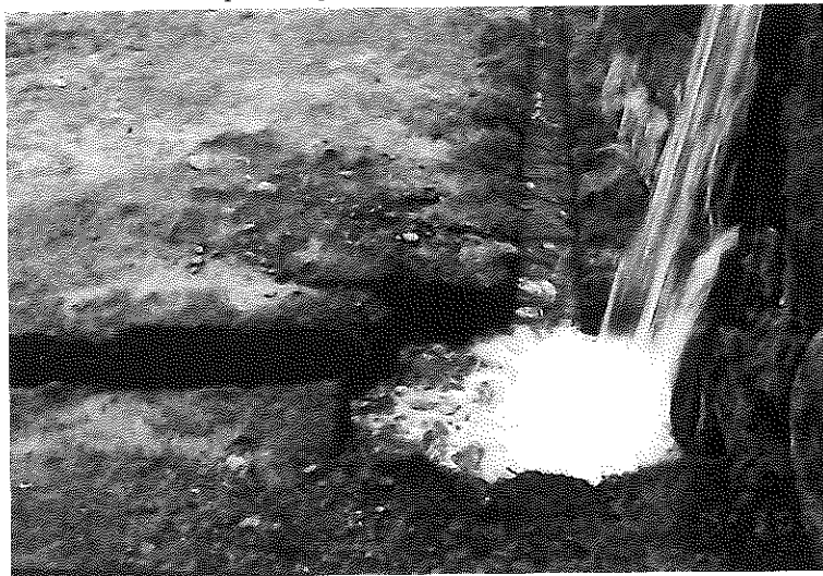
FOTO 8.- Poza disipadora aguas abajo del salto del canal entre dos terrazas
