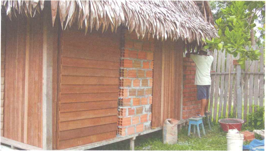
Figura 6. Construcción de muro de ladrillos. Fotografía: Manuel Villena, 2011
