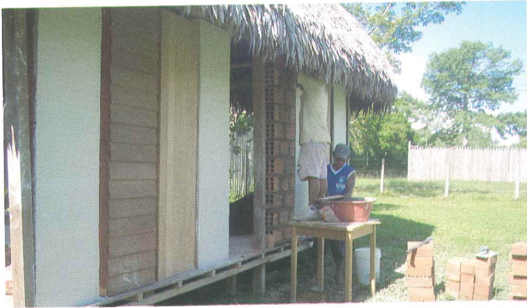
Figura 9. Descripción de paneles y muros. Fotografía: Manuel Villena, 2011
