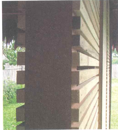
Figura 12. Muro con ripas de madera. Fotografía: Manuel Villena, 2011
