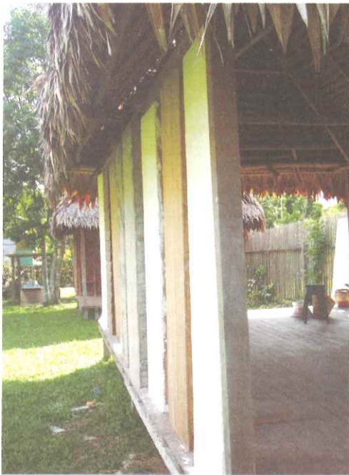
Figura 7. Ubicación de muestras constructivas en exterior. Fotografía: Manuel Villena, 2011
