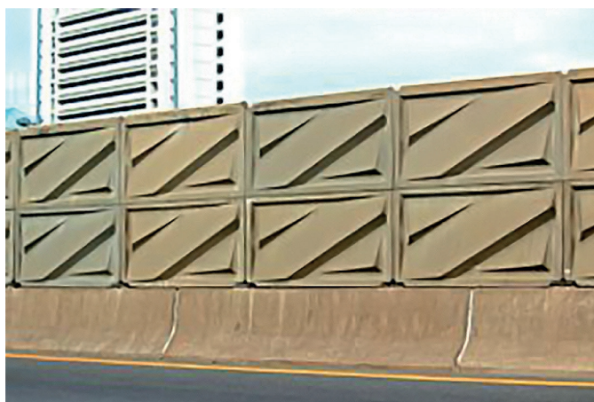
Figura 3. Pantalla acústica de hormigón. Fuente: Paneles ACH.
