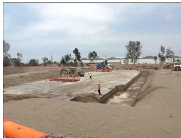
Figura 7. Vista de la conformación de las capas de relleno hidráulico fluido. (fuente: Geomaster SAC.)
