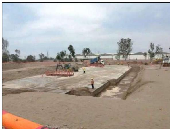
*Figura 7. Vista de la conformación de las capas de relleno hidráulico fluido.
