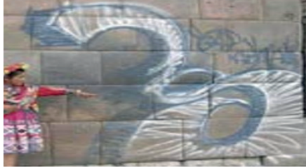
Figura 1. Deterioro de muro Inca en plaza de Las Nazarenas
