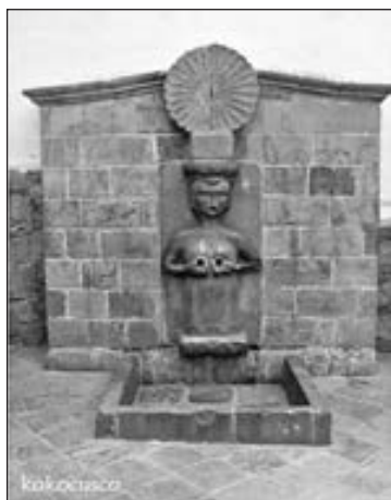
Pileta actual restaurada.
